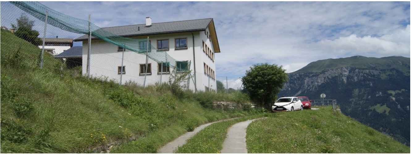
Ansicht ehemaliges Schulhaus in Mathon
